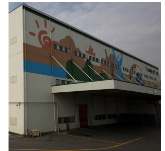
대전2공장 (PET병, PET프리폼) 대전광역시 대덕구 신일서로17번길 93
